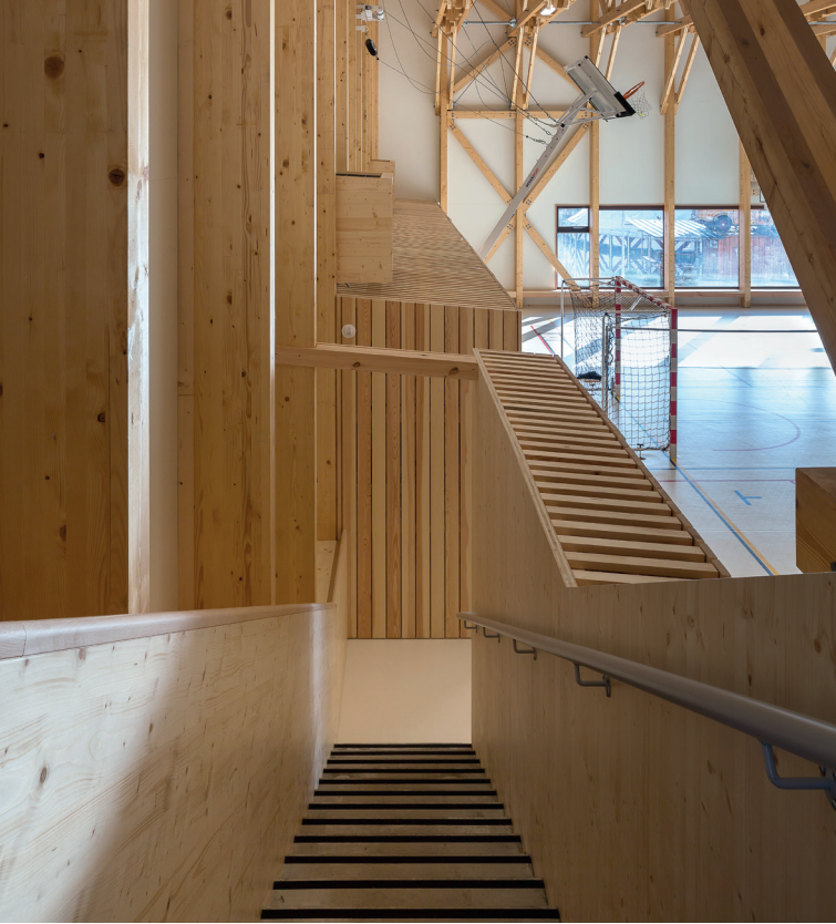
Blick von der zum ersten Stock führenden Treppe aus auf die Innenausbauten aus Kiefer und Fichte
